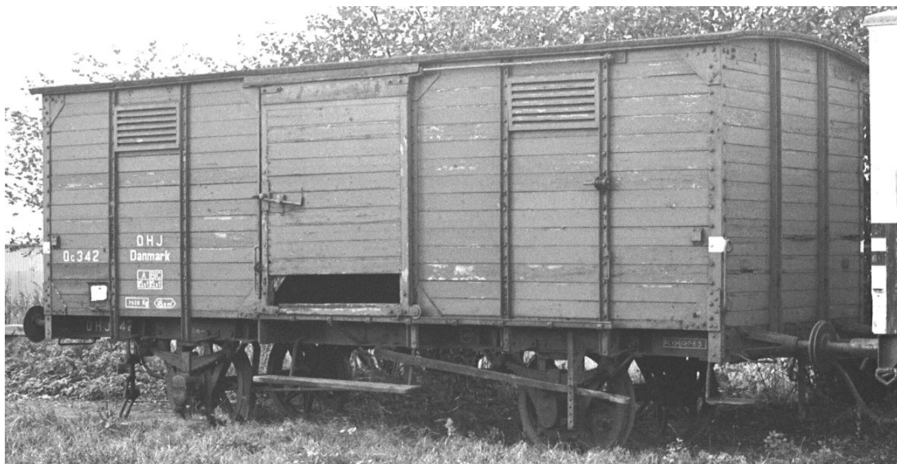
OHJ Qc 342, med ventilationsriste, tara 7520 kg, ABC-last 15,5 t og Bdf1 18,5 m 2 . Svinninge 02.11.1974 © P.T.Nielsen
